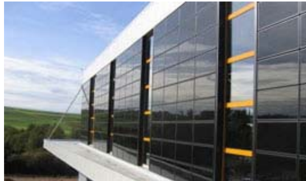
Figur 11: Tynnfilm solcellemoduler integrert i fasade [14].
