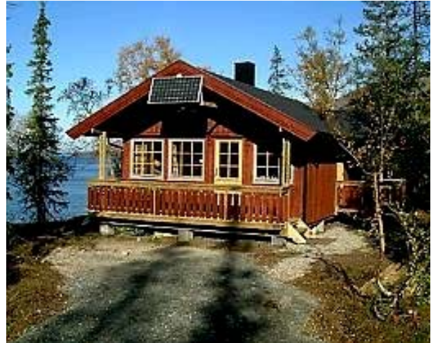
Figur 9: Solcellepanel kan forsyne hytta med strøm til lys og evt. drift av kjøleskap [13].
