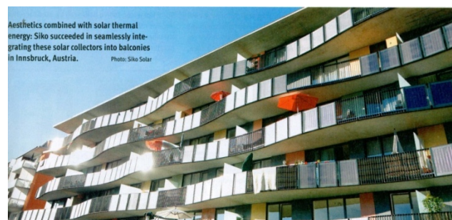
Figur 17: Plane solfangerpanel integrert i balkongrekkverk i Innsbruck, Østerrike [18].
