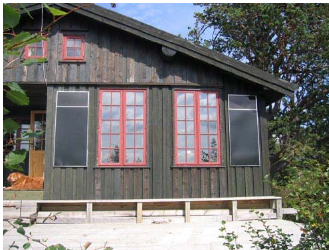
Figur 18: Luftsolfangere på en hytte i Telemark ( www.hytteavisen.no ).
