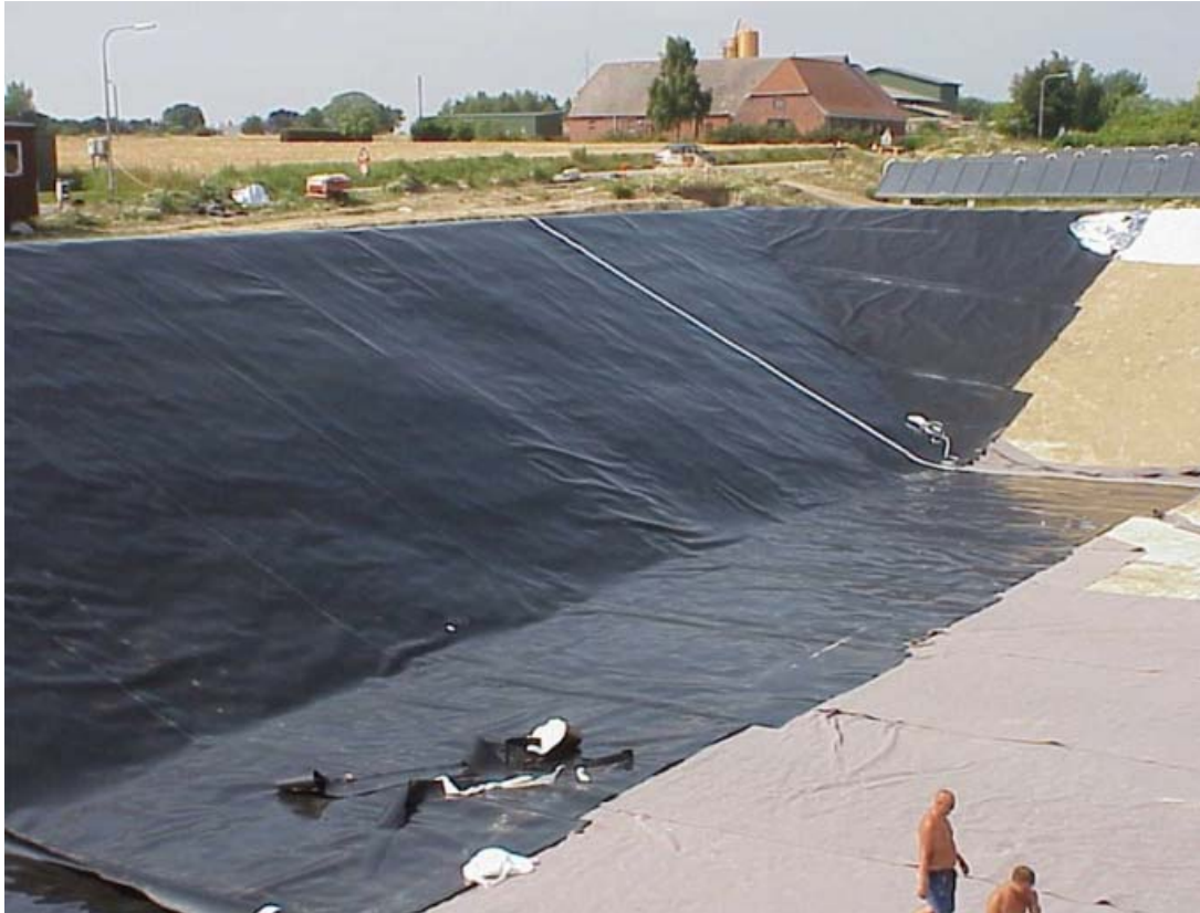
Figur 21: Gruslager ved Marstal Fjernvarme [20].
